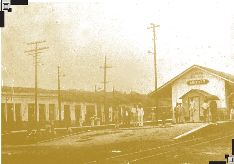
Estação Ferroviária de Merity (atual Duque de Caxias), anos 1920. Acervo Instituto Histórico/CMDC.
